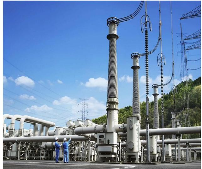
GIS 局放在线监测及诊断的任务是了解和掌握设备的运行状态，包括采取各种检测、测量、监视、分析和判别方法，结合系统的历史和现状，考虑环境因素，对设备运行状态进行评估，判断其处于正常或非正常状态，并对状态进行显示和记录，对异常状态作出报警，以便运行人员及时处理，并为设备的故障分析、性能评估、合理使用和安全生产工作提供信息和准备基础数据。实现开关绝缘的状态检修，减少停电时间和节省管理维护成本。
